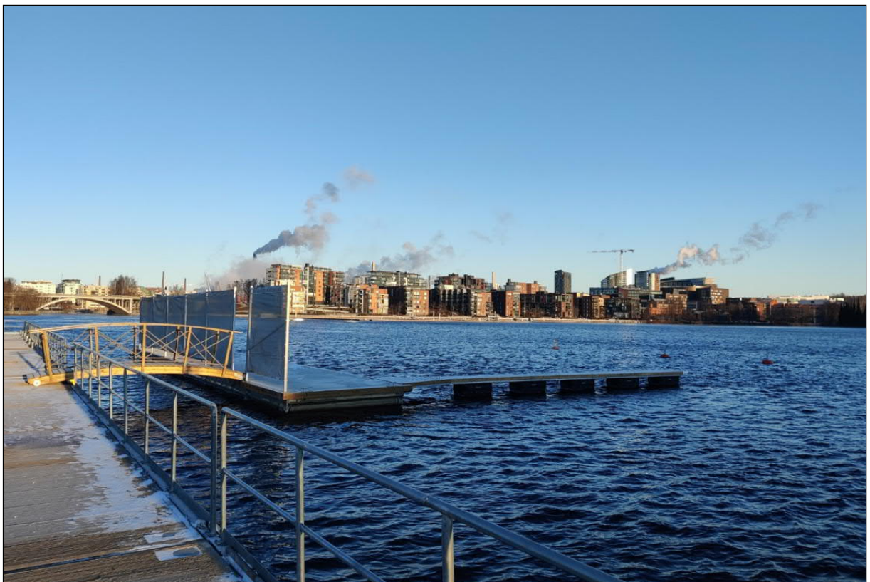
Kuva 3. Saunalauttalahituri kuvattuna aallonmurtajalahiturilta.
